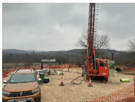
Slika br. 2. Rotaciono bušenje sa jezgrovanjem Izvor: Autor
